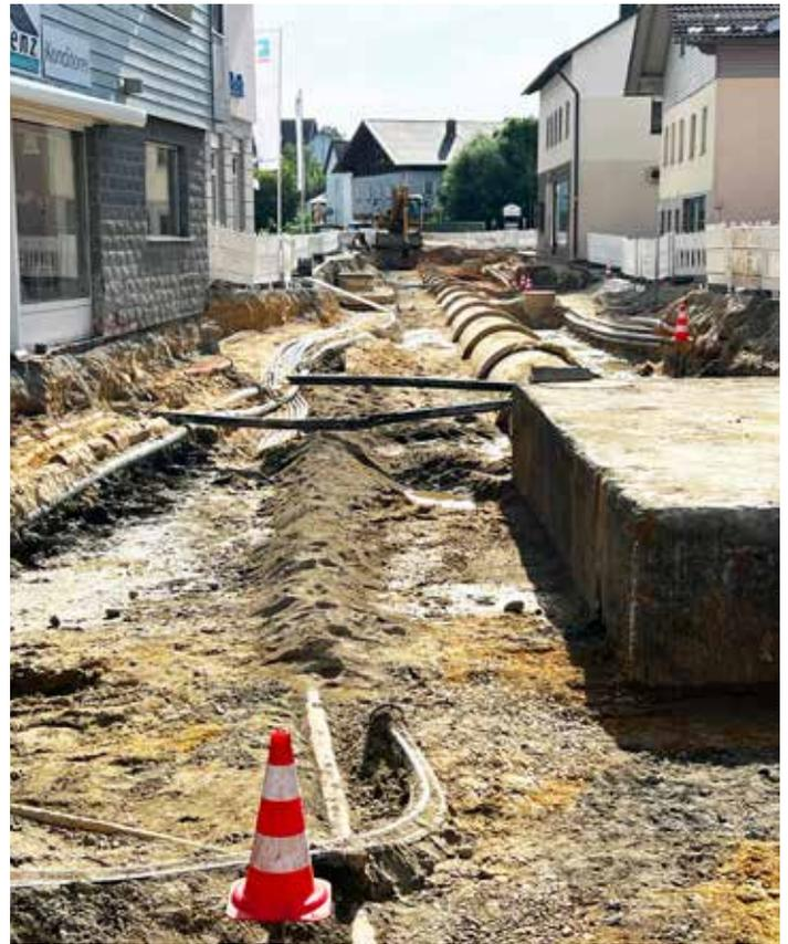
Im Rahmen der Marktplatzsanierung erhält die Waldstraße derzeit eine neue Asphalttragschicht. Dafür wird der Boden ausgetauscht und eine neue Frostschutzschicht eingebaut. Auch die Gehwege werden erneuert, weshalb vorerst nicht nur die Straße gesperrt ist, sondern auch der Zugang zu den Geschäften an der Waldstraße erschwert ist. Sie sind - über kleine Umwege - dennoch erreichbar. Über den Fortschritt der Arbeiten informierte Bür-
