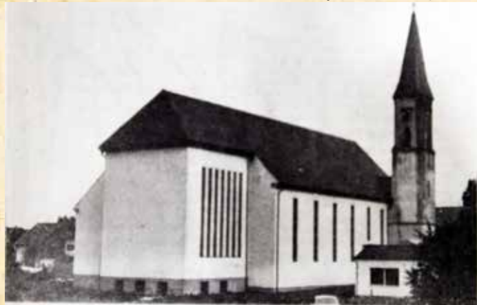
Auf dem ruhigen Wahrzeichen des Marktes Schöllnach, dem Kirchturm, soll demnächst ein Elektro-Geläute und eine neue Turmuhr montiert werden. Auch das Dach und die Fassaden werden erneuert, sobald diese Arbeiten finanziert werden können.
