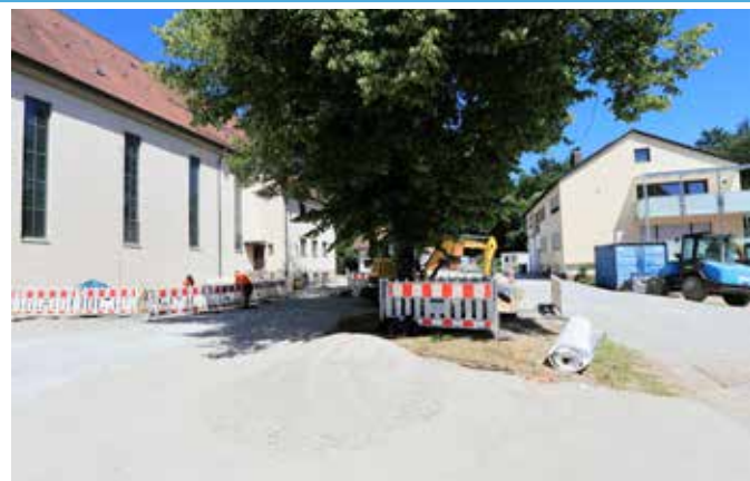
Die Arbeiten zur Marktplatzsanierung konzentrieren sich aktuell im Umfeld der Kirche. Zur Stabilisierung des Bodens wurden Geo- gitter ausgelegt, die archäologischen Untersuchungen laufen. Am Parkhaus hinter der Kirche wurden mittlerweile auch die Lade- säulen aufgestellt. sas-medien - Foto: sas-medien
